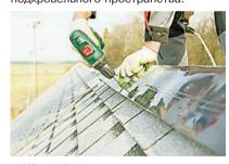
**Шаг 11.** Аэратор закрывают коньково-карнизной черепицей; каждый элемент фиксируют двумя гвоздями. Укладку следует вести со стороны, противоположной преобладающему направлению ветра.
