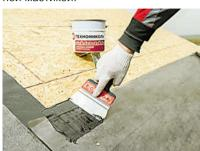
**ШАГ 5.** Вдоль внутренних переломов крыши (ендов), поверх подкладочного ковра следует уложить ендовный ковер; с тыльной стороны его края требуется промазать мастикой на ширину около 10 см.
