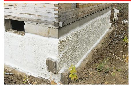
крепежа. Теп-лоизоляцию нужной толщины получают за один или несколько проходов. Готовый слой прочен и герметичен. В нём отсутствуют зазоры и стыки.
