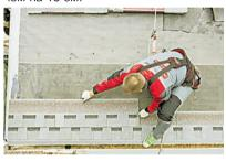
**Шаг 10.** В случае утеплённой крыши конёк закрывают пластиковым кровельным аэратором. Он позволит лишней влаге свободно выходить из подкровельного пространства.
