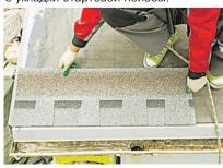
**Шаг 8.** Черепицу крепят кровельными гвоздями с широкой шляпкой. Если угол наклона крыши менее 45°, на каждый гонт требуется 5 гвоздей, если более 45° - 8.
