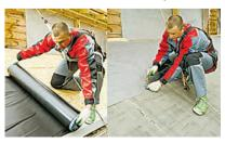
**ШАГ 4.** Стыки полос подкладочного ковра желательно проклеить кровельной мастикой.
