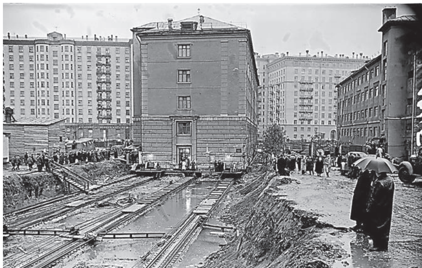
Перемещение дома в связи со строительством трассы Восточный луч, 23 сентября 1958 г.
