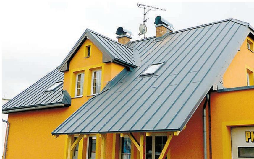
**СРЕДИ МНОГООБРАЗИЯ СОВРЕМЕННЫХ КРОВЕЛЬНЫХ ПОКРЫТИЙ МОЖНО ВЫДЕЛИТЬ СТАВШИЕ В ПОСЛЕДНЕЕ ВРЕМЯ СНОВА ПОПУЛЯРНЫМИ ФАЛЬЦЕВЫЕ КРОВЛИ. ОСОБЕННОЕ ВНИМАНИЕ К ЭТОЙ ТЕХНОЛОГИИ МОЖНО ОБЪЯСНИТЬ ЕЁ ПРОГРЕССИВНОСТЬЮ, НАДЁЖНОСТЬЮ, УНИВЕРСАЛЬНЫМ ПРИМЕНЕНИЕМ, ПРОСТОТОЙ МОНТАЖА.**
