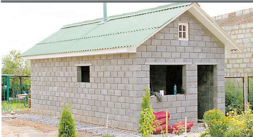
**СОВРЕМЕННЫЕ СТРОИТЕЛЬНЫЕ МАТЕРИАЛЫ ЯВЛЯЮТСЯ ВПОЛНЕ ДОСТОЙНОЙ АЛЬТЕРНАТИВОЙ ДОРОГОЙ И НЕ ВСЕГДА ДОСТУПНОЙ ДРЕВЕСИНЕ. БАНЯ, ИЗГОТОВЛЕННАЯ ИЗ КЕРАМЗИТОБЕТОННЫХ БЛОКОВ, ДАЖЕ СПУСТЯ 10 ЛЕТ ХОРОШО СОХРАНЯЕТ СВОИ ХАРАКТЕРИСТИКИ. НО ПРИ НЕСОБЛЮДЕНИИ ПРАВИЛ СТРОИТЕЛЬСТВА И ДАЛЬНЕЙШЕЙ ЭКСПЛУАТАЦИИ МОГУТ ОТМЕЧАТЬСЯ НЕКОТОРЫЕ ПРОБЛЕМЫ.**
